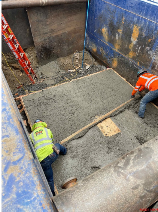
Concrete Pour for Dry Well Slab
